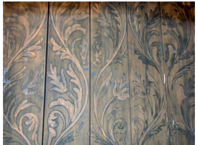
Verzierte Schwelljalousien, fotografiert während der Sanierung 2018/19 nach Abbau der Gitterornamente.
