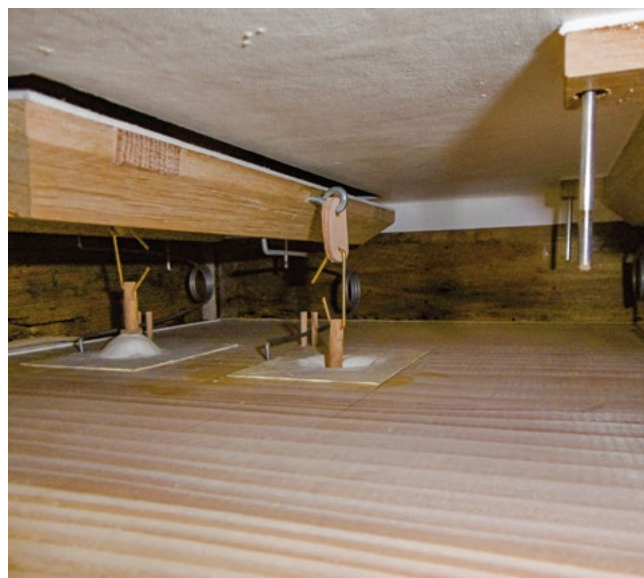
Pedallade, wiederhergestellte Ventile mit seitlichem Aufgang.
