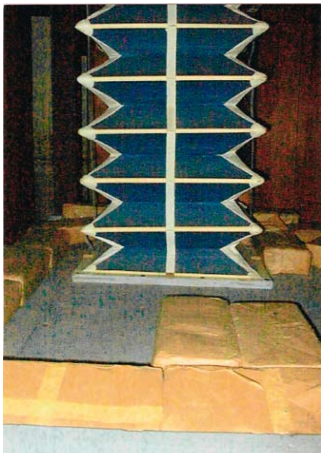
Eupen, Ziehharmonikabalg zwischen Magazinbalg und Windlade.
